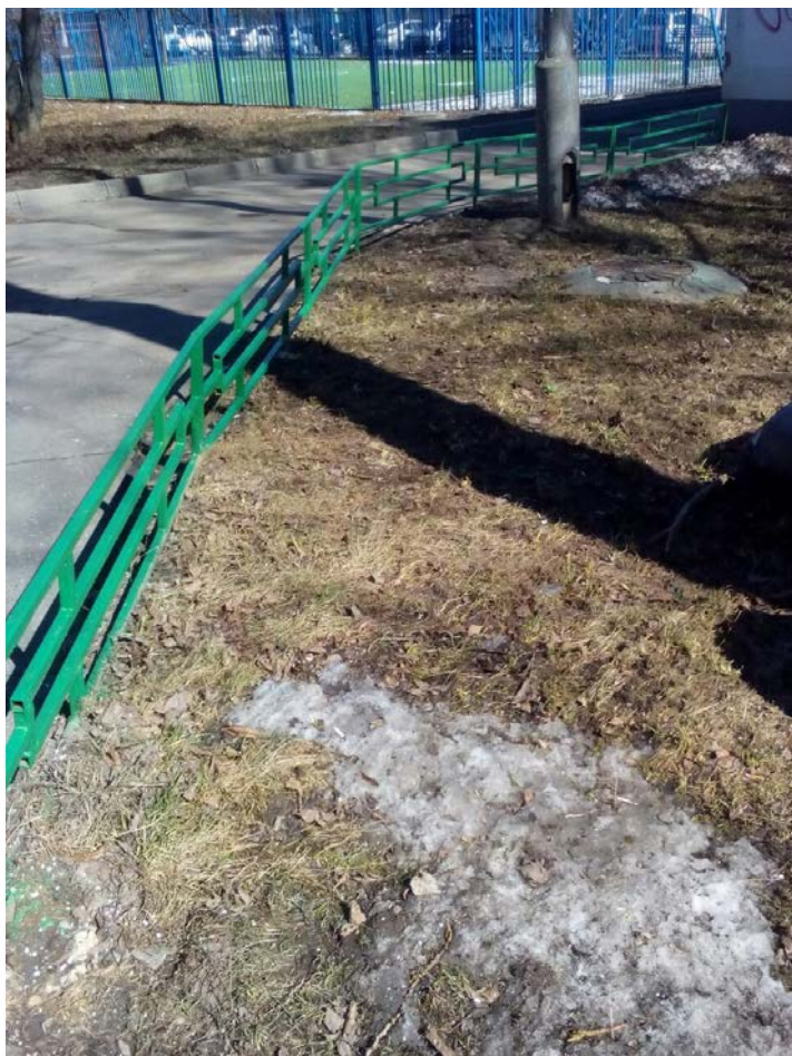
Дворовая территория по ул. 2-я Пятилетка д. 2, 4
